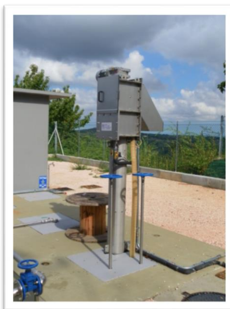
Figure 19 : Représentation d'un dégrilleur automatique vertical
