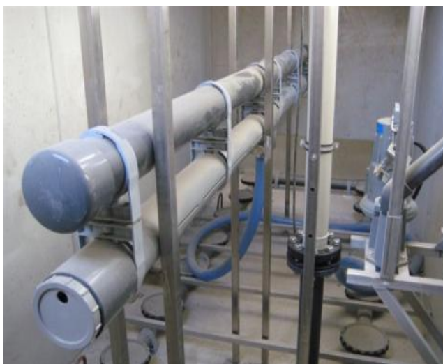
Figure 14 : Exemple d'une rigole de reprise des eaux montée dans le réacteur
