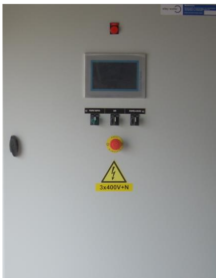
Figure 16 : Exemple d'une armoire de commande intérieur
