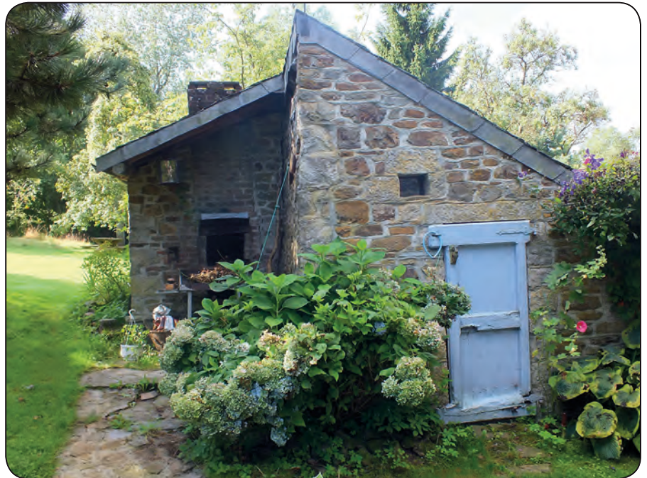
Fournil, rue du Coreux 15.
