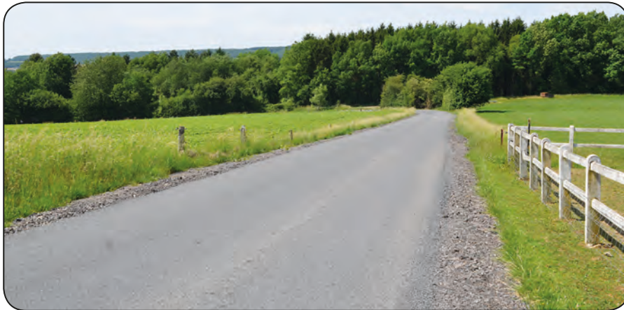
Route Tour du Diable - Bohon. Reprofilage et enduisage.
