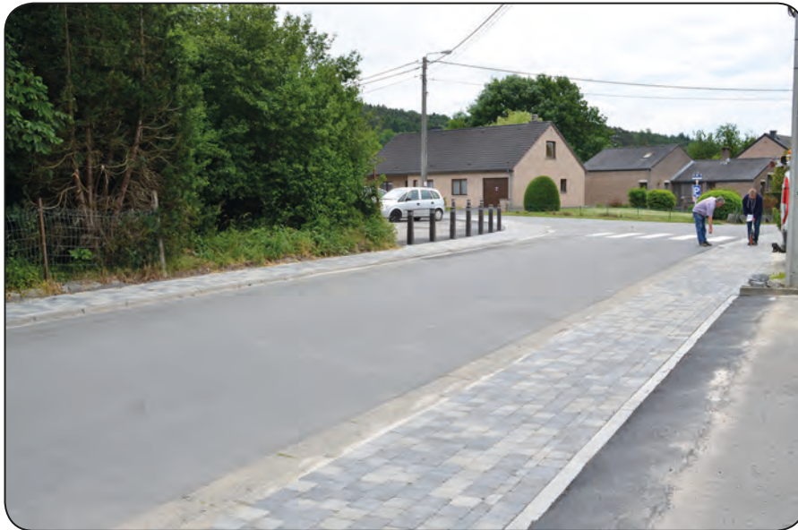
Barvaux, rue de l'Aite, rénovation des trottoirs.
