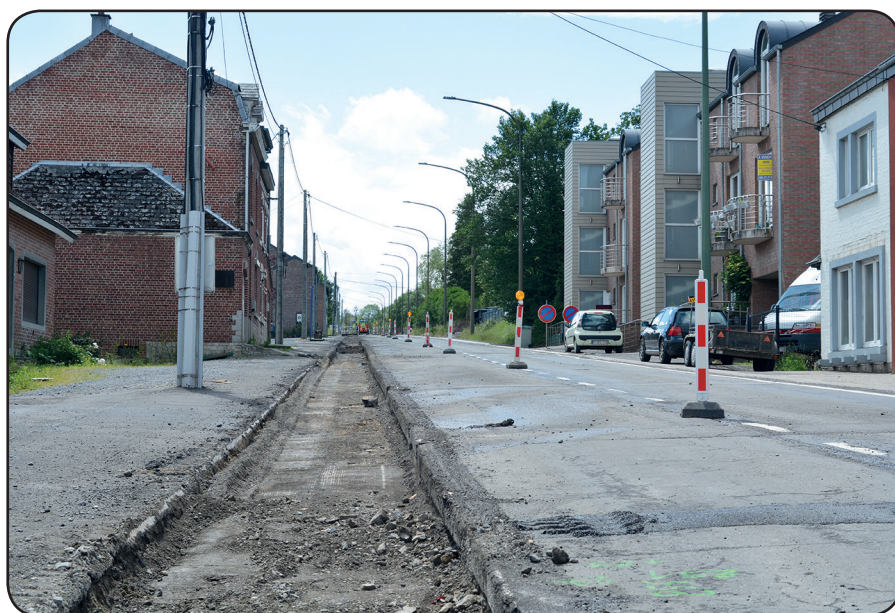
Les travaux de rénovation de la RN 983
