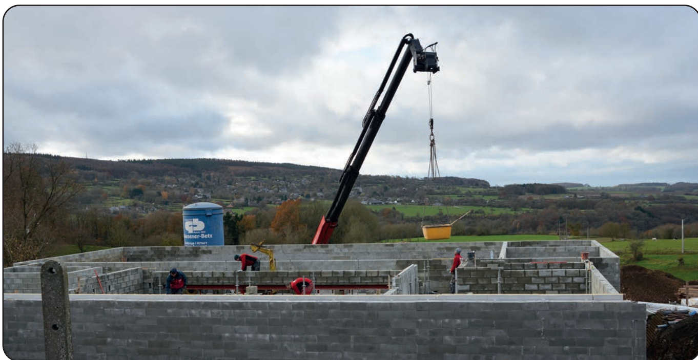
Construction de la Maison Rurale Polyvalente d'Izier.
