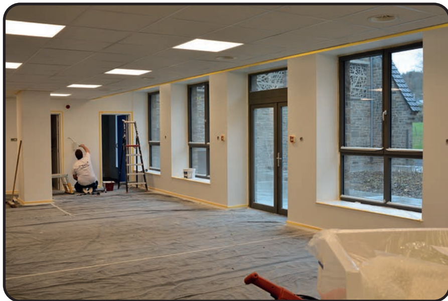
Nouvelle crèche d'une capacité de 24 enfants, aménagée au rez-de-chaussée du bâtiment des Pères Oblats
