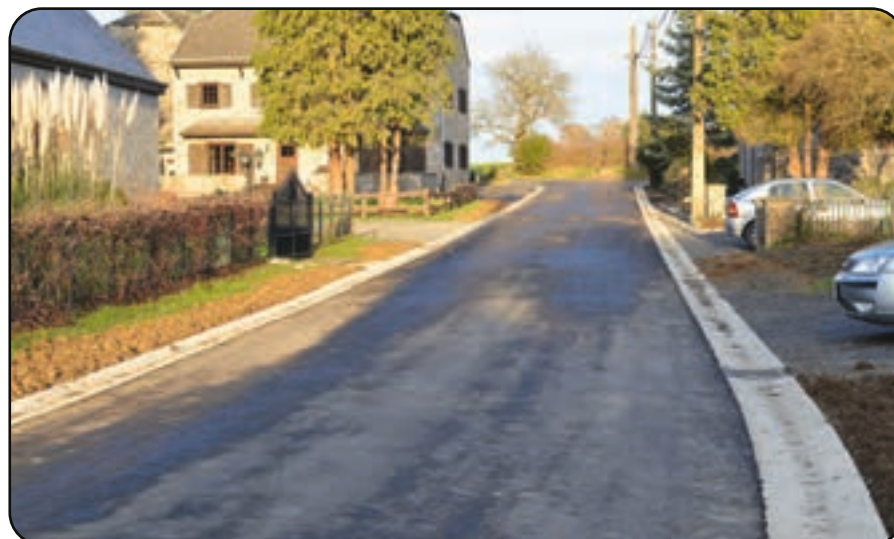
Réfection de voiries à Warre
