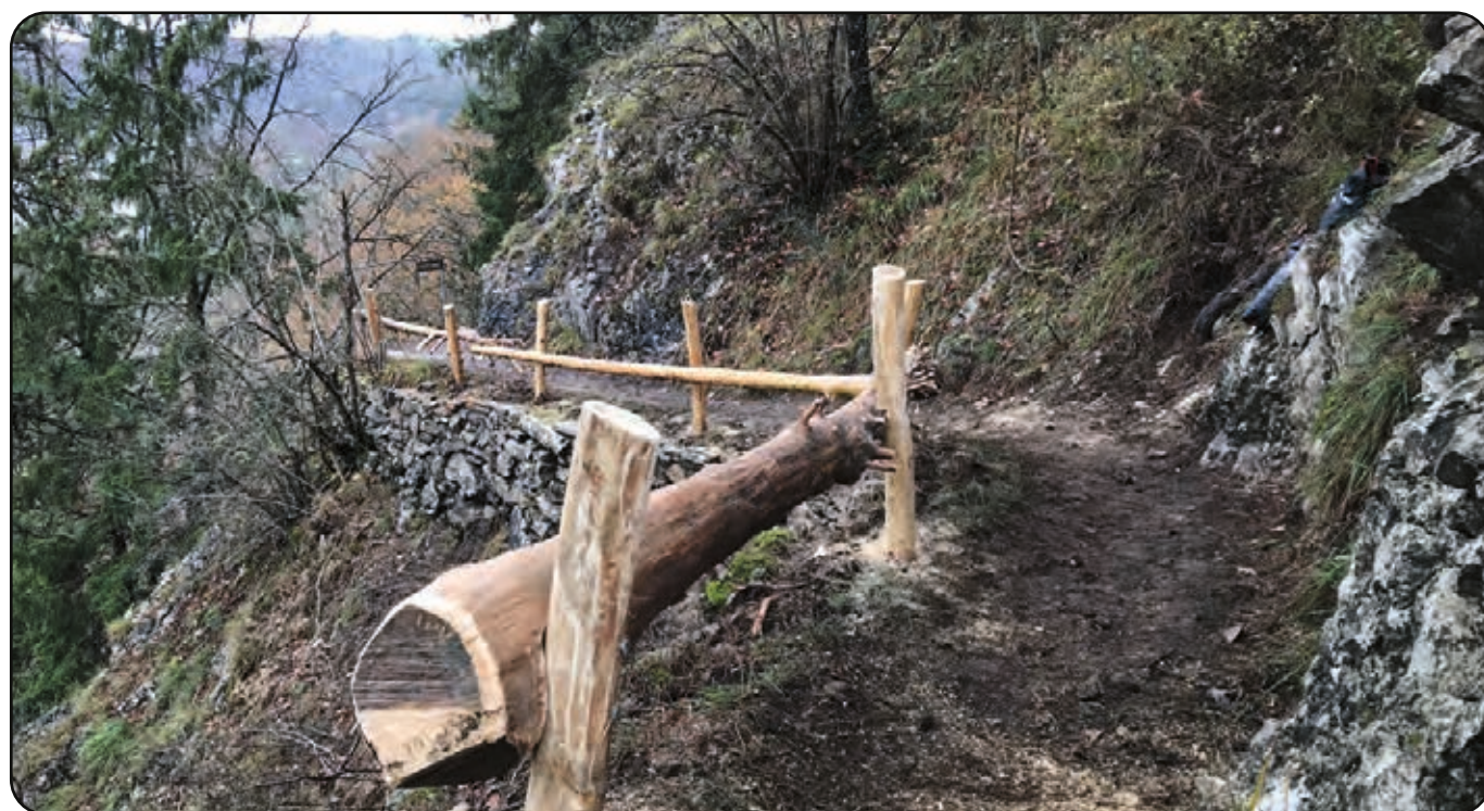
Le sentier après rénovation
