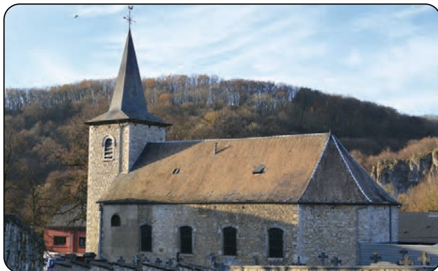
Eglise de Bomal, le remplacement de la toiture va débuter.
