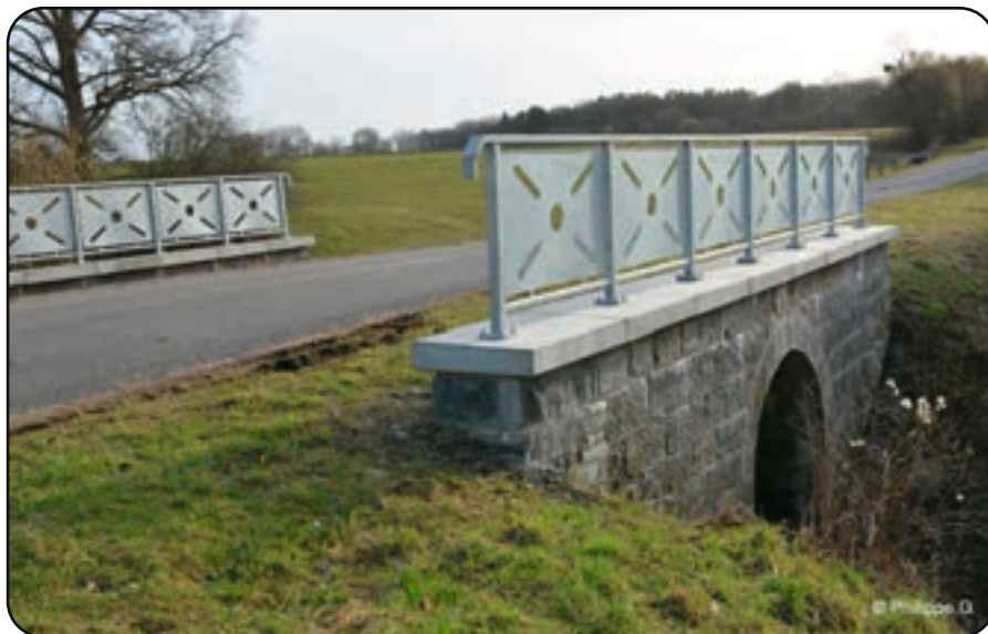
Le pont de Ny à Oppagne
