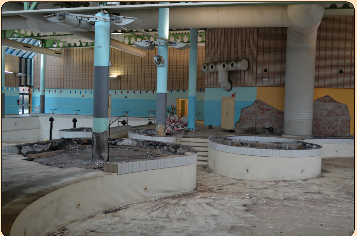
Le chantier de rénovation, les travaux devraient reprendre dans le courant du premier trimestre 2022.
