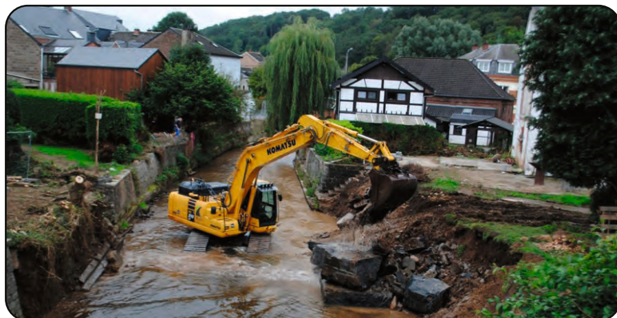
Bomal, réfection des berges de l'Aisne. Photo Julien Bil.
