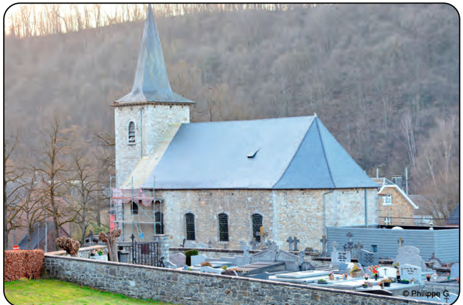
Bomal, renouvellement de la toiture de l'église.
