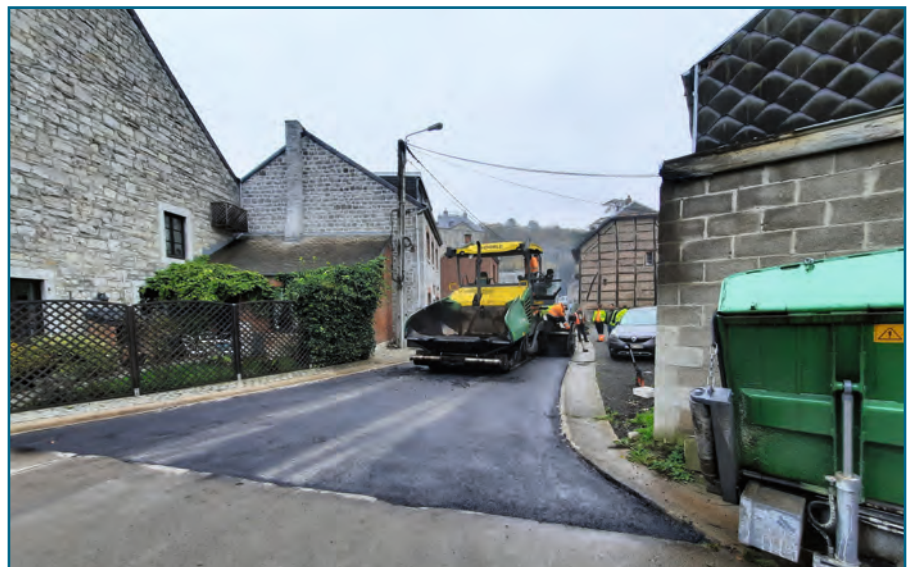
Bomal, rénovation de la rue Vinâme.
