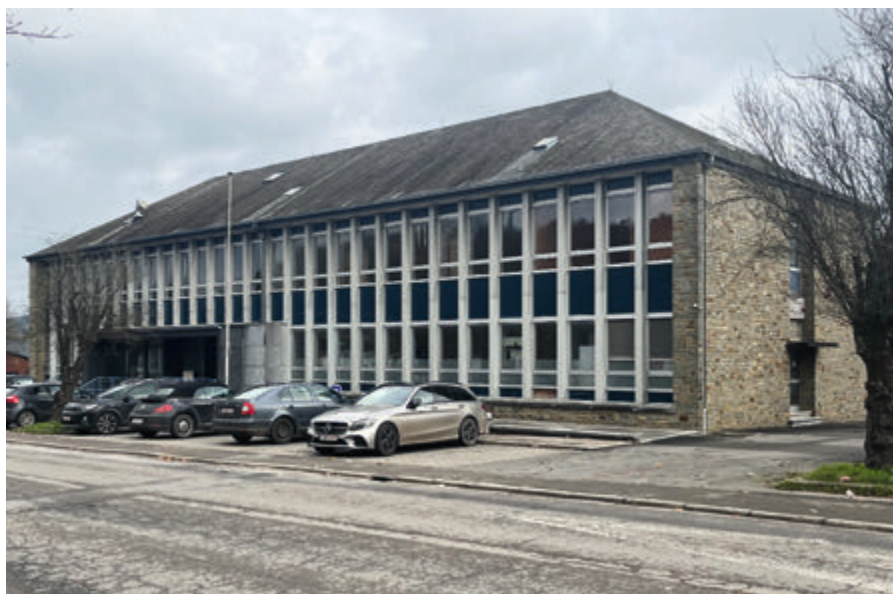
Barvaux, l'ancienne Poste et l'Administration du cadastre et de l'enregistrement
