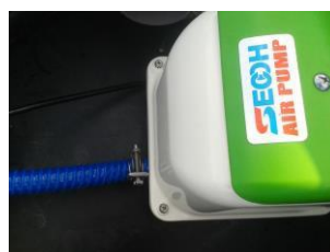
Fig-20 : Raccordement côté surpresseur (27EH)
