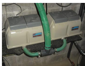
Fig-22 : Raccordement côté surpresseur (38EH MB)
