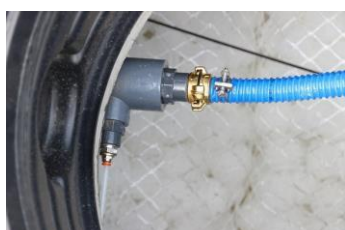
Fig-19 : Raccordement côté réacteur biologique (27EH)
