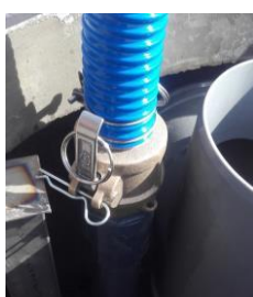
Fig-21 : Raccordement côté réacteur biologique (38EH MB)
