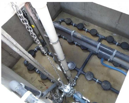
Figure 11 : Vue sur une rampe d'aération avec diffuseurs fines bulles disque 9"
