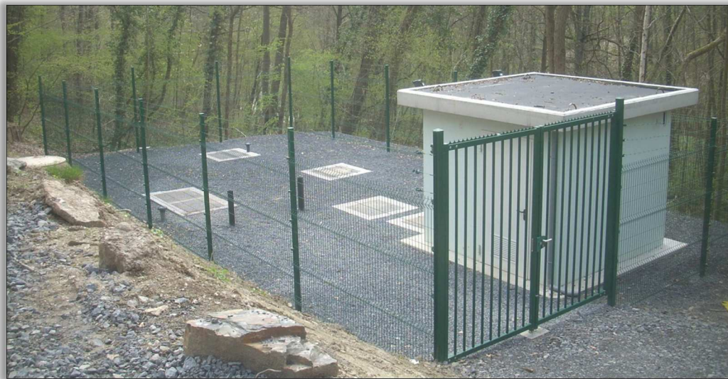
Figure 1 : Vue station d'épuration de 300 EH enterrée à Wépion (Belgique)
