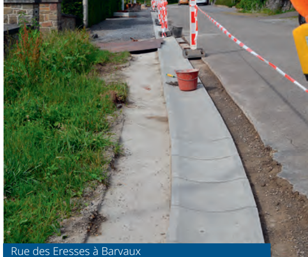
Rue des Eresses à Barvaux
