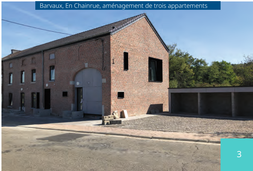
Barvaux, En Chainrue, aménagement de trois appartements
