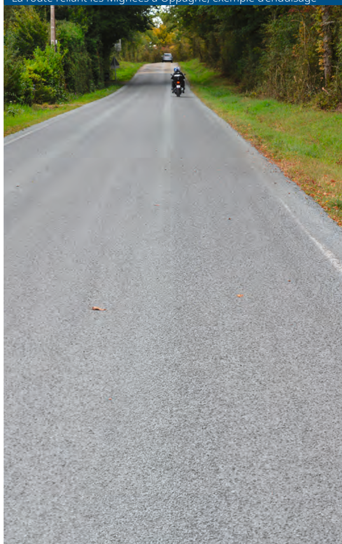
La route reliant les Mignéas à Oppagne, exemple d'enduisage
